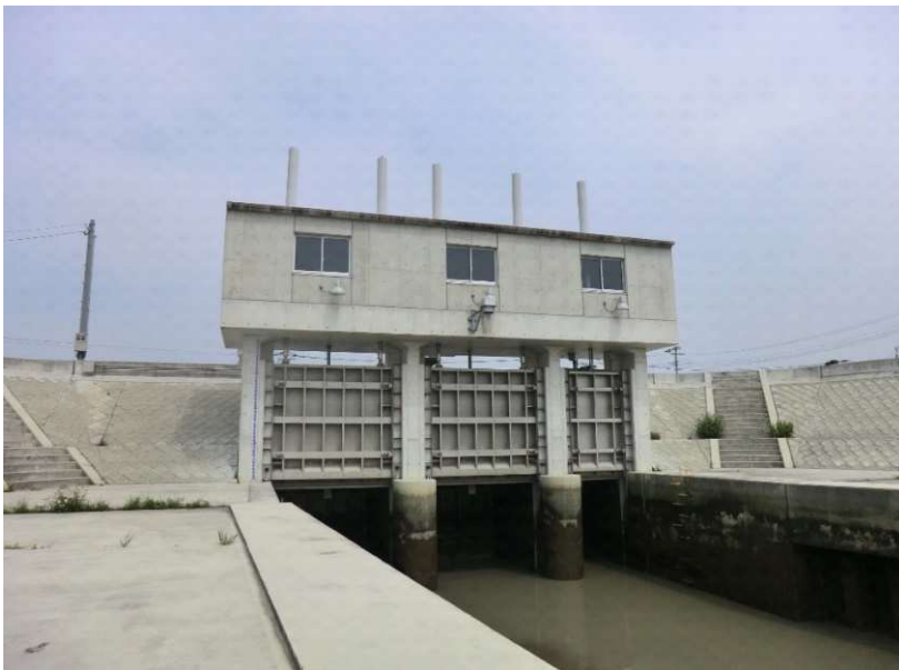
引き上げ式ゲートの例
