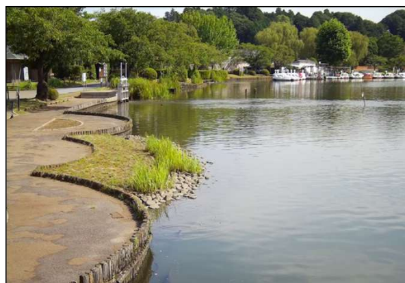
R6.7.25 通水あり
