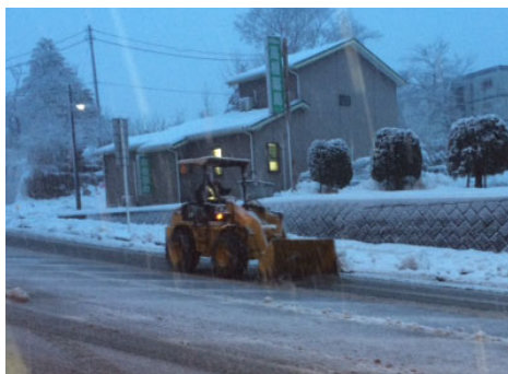
〈除雪作業（タイヤショベル）〉
