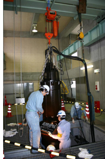
〈排水設備点検〉
