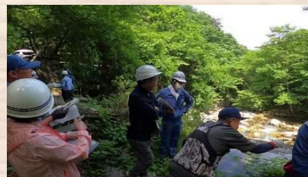
点検の様子 餅ヶ瀬川三号砂防堰堤
