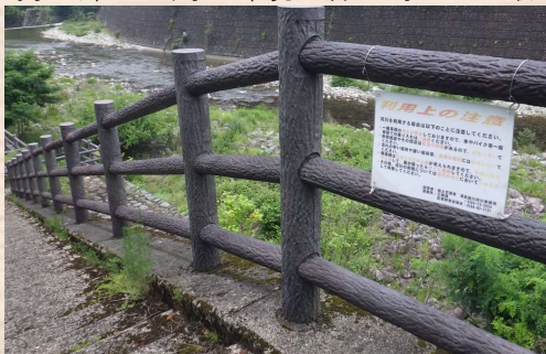
通洞床固群（足尾管内） 階段・柵・注意看板の状況確認
