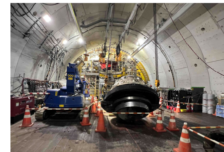
写真③：1次解体状況
