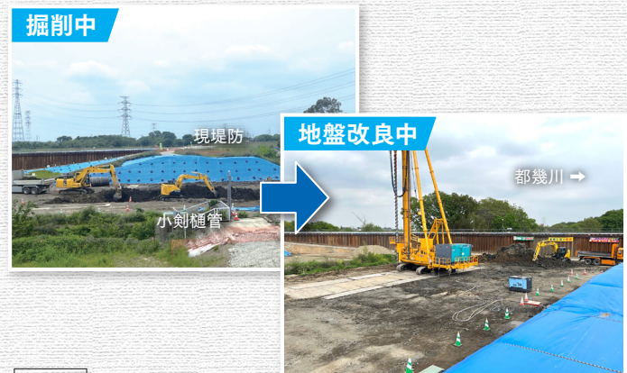
地盤を固くする(地盤改良)工事の様子
