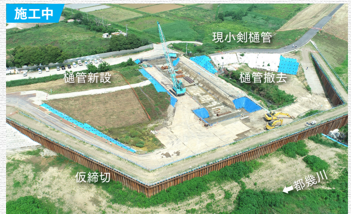
地盤を固くする(地盤改良)工事の様子
