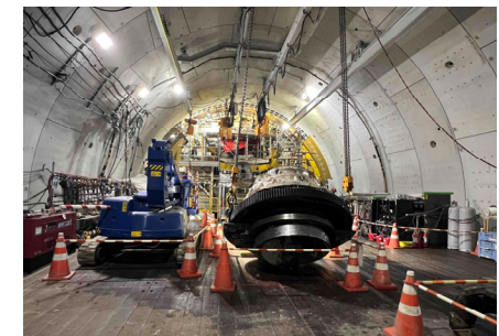
写真③：1次解体状況
