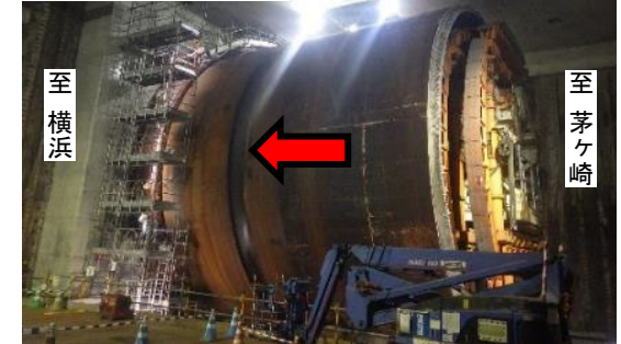
写真①：シールドマシンの前移動（完了）
