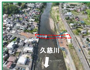
工事箇所の全景（下流から）
