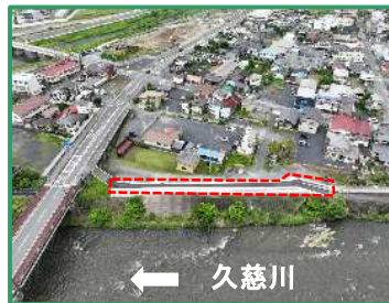
工事箇所の全景（左岸から）
