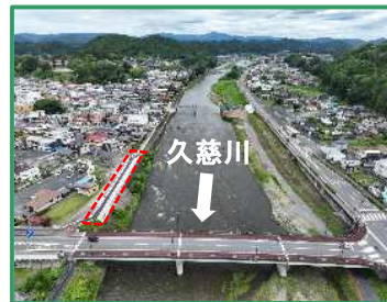
工事箇所の全景（下流から）
