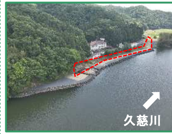
工事箇所の全景（右岸から）
