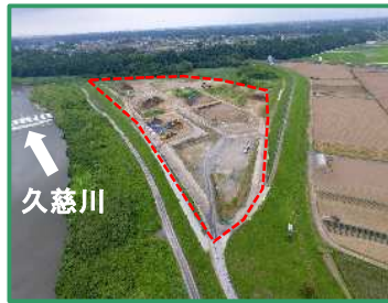
工事箇所の全景（上流から）
