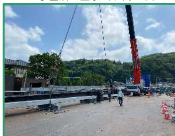
橋桁の揚重作業を行っています
