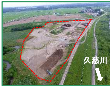
工事箇所の全景（下流から）
