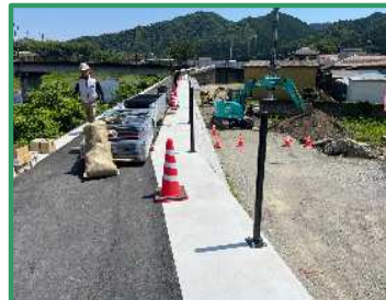
防護柵の設置を行っています
