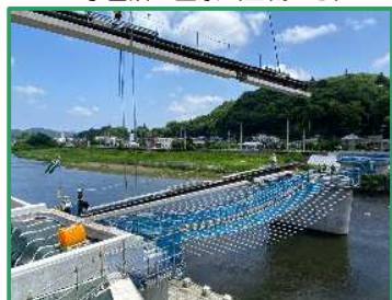
橋桁の揚重作業を行っています
