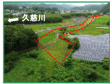
工事箇所の全景（下流から）
