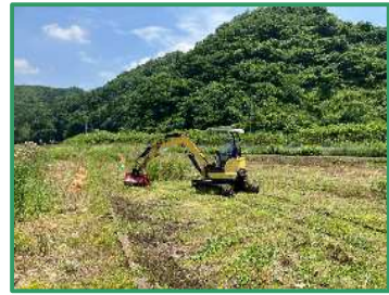
除草作業を行っています
