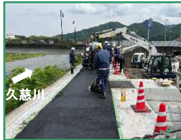
アスファルト舗装を行っています
