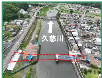
工事箇所の全景（上流から）
