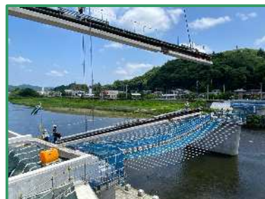
橋桁の揚重作業を行っています
