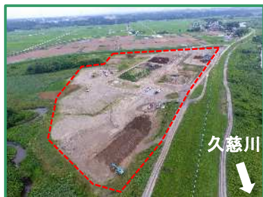
工事箇所の全景（下流から）
