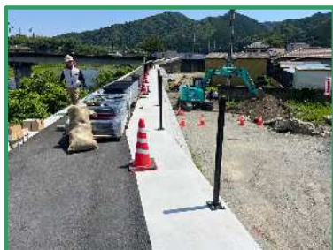
防護柵の設置を行っています
