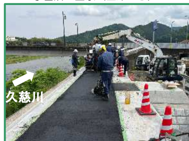
アスファルト舗装を行っています
