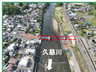
工事箇所の全景（下流から）
