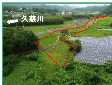
工事箇所の全景（下流から）
