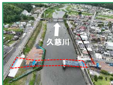
工事箇所の全景（上流から）
