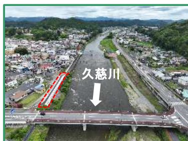
工事箇所の全景（下流から）
