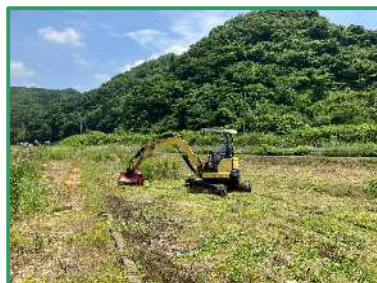
除草作業を行っています
