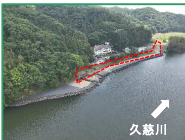
工事箇所の全景（右岸から）
