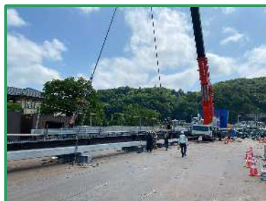
橋桁の揚重作業を行っています
