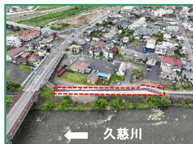
工事箇所の全景（左岸から）
