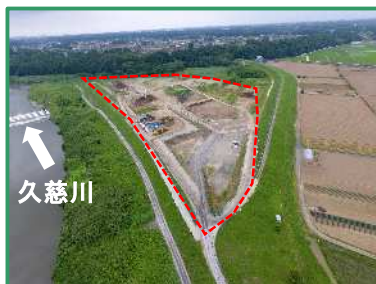
工事箇所の全景（上流から）
