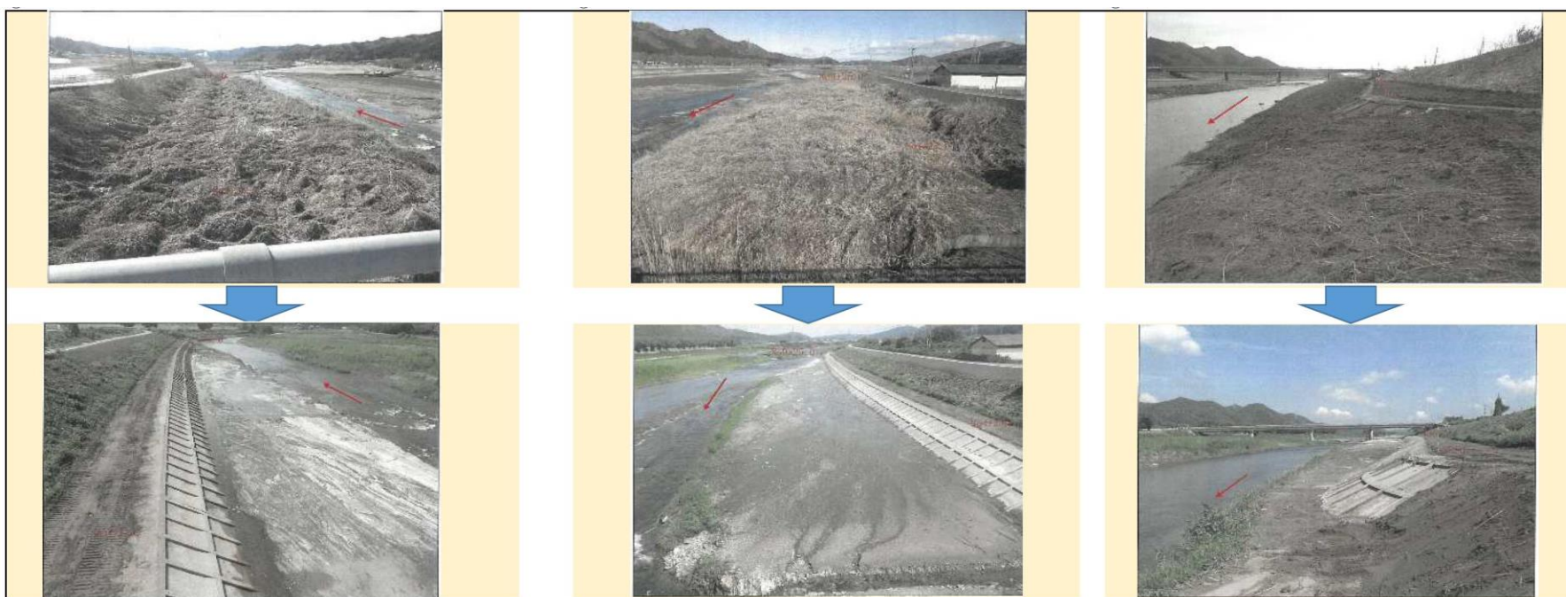
久慈川における河道掘削の実施状況（撮影場所：矢祭町中石井）
