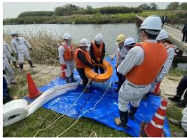
排水ポンプ投入
