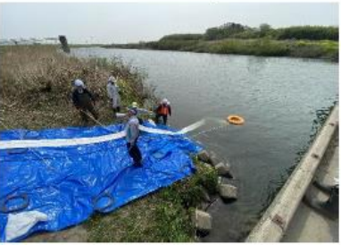
排水ポンプ投入
