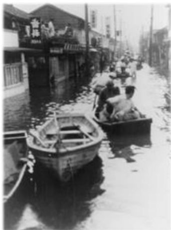
昭和33年9月狩野川台風 による被害（葛飾区）
