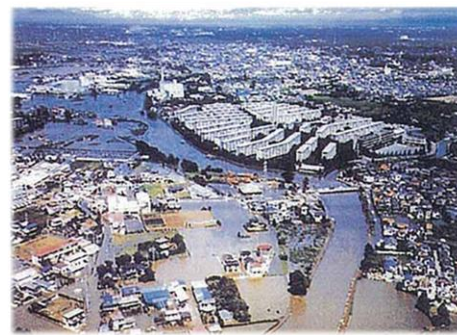
昭和61年8月洪水 による被害（越谷市）
