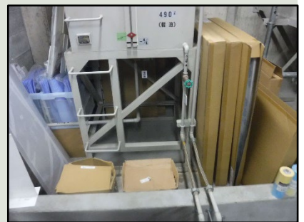
③防油堤内の整理
