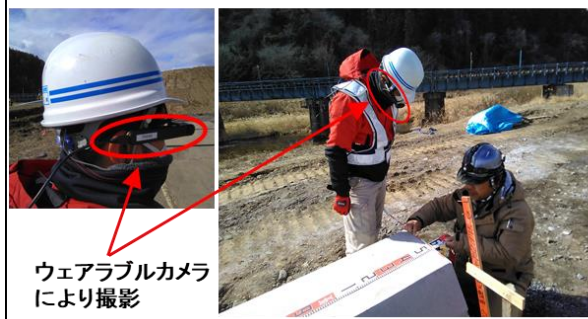
現場での受注者による撮影状況
