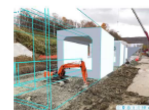
掘削作業時にARと比較
