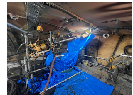
写真④：先受け鋼管の打設状況
