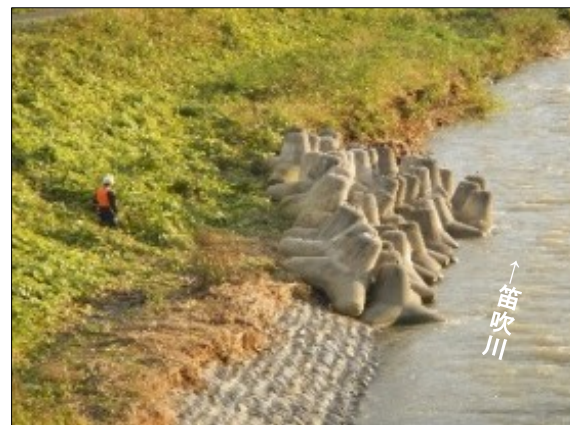
応急復旧後(根固ブロック設置状況)
