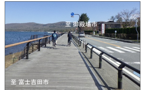
① 整備済み区間
