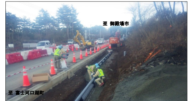
② 工事状況
