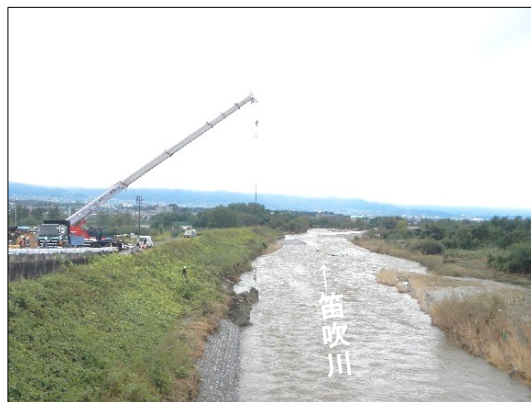
応急復旧状況(R1年洪水)
