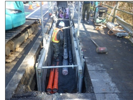
施工状況(鳴沢電線共同溝)
