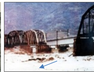
東海道本線鉄橋の流失
