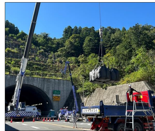
応急復旧工事の状況
