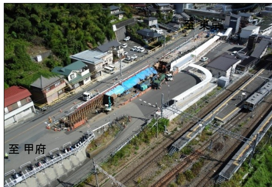
① 施工状況(全景)
