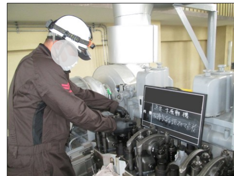
機械設備の点検
