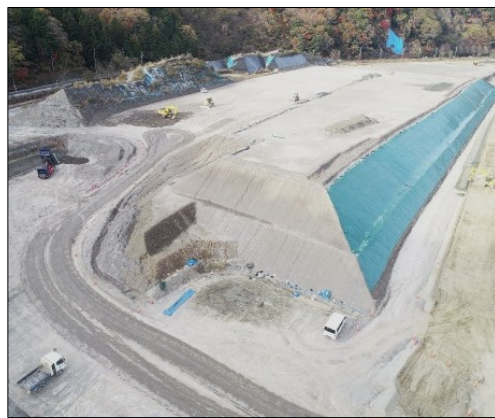
トンネル残土造成工事（栗倉地区）
