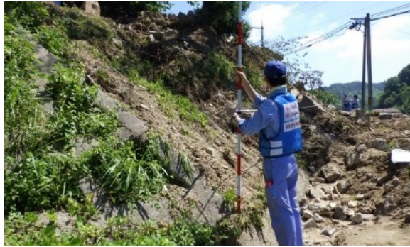
被災状況調査
