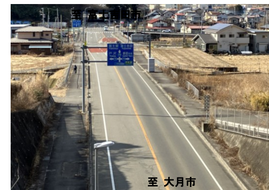
開通状況(都留市玉川地区)
