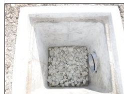
雨水貯留浸透枡整備事例(昭和町)
