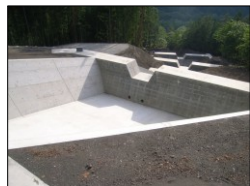
塩島沢堰堤群(富士川砂防事務所)
