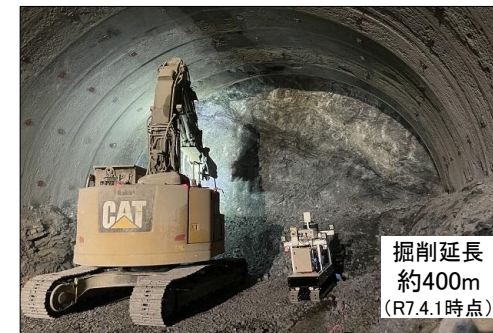
トンネル掘削状況
