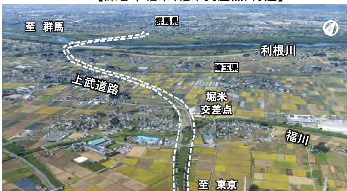
ふかや ほりごめ 【深谷市堀米(堀米交差点)付近】
