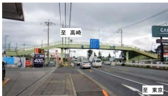
【橋梁全景(下り線より終点を望む)】
