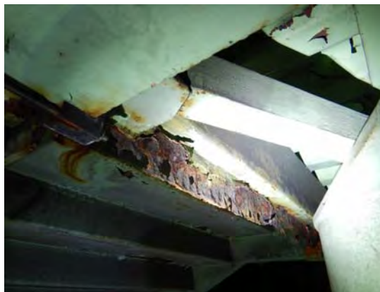
・地覆の腐食 <地覆補修>
