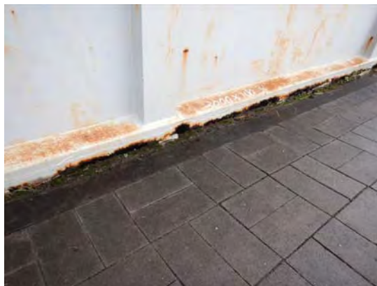
・地覆の腐食 <地覆補修>
