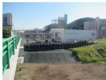
▲ 中橋右岸側(川表から) 完成時
