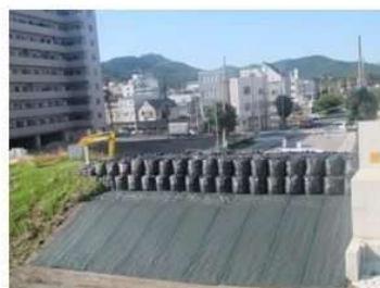
▲ 中橋左岸側(川表から) 完成時
