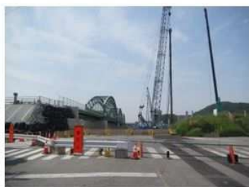
▲ 中橋左岸側(川裏から) 着工前
