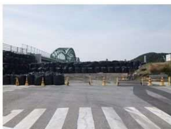
▲ 中橋左岸側(川裏から) 完成時
