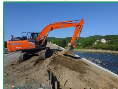
堤防盛土の工事を行っています
