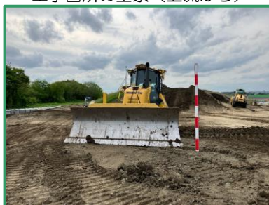
堤外盛土の工事を行っています
