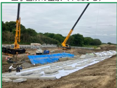
ブロック張りの工事を行っています
