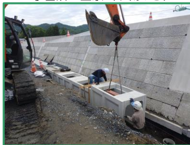
堤脚水路の工事を行っています
