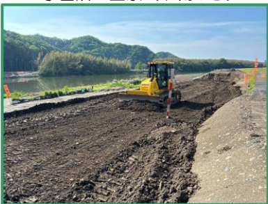
堤防盛土の工事を行っています
