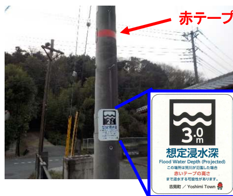
電柱(東電柱)の設置状況
