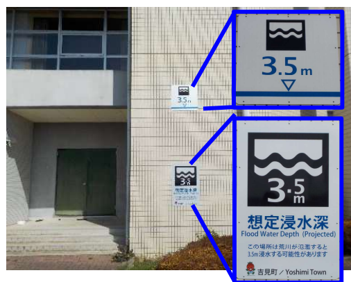
公共施設等壁面の設置状況
