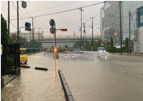
美女木東地下道
