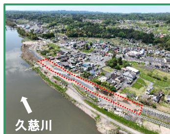
工事箇所の全景（上流から）
