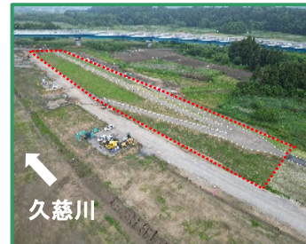
工事箇所の全景（上流から）
