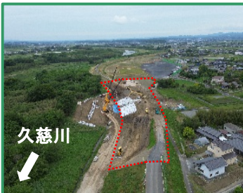
工事箇所の全景（下流から）
