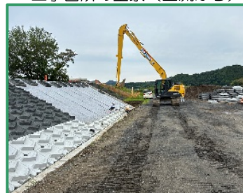
ブロック張りの工事を行っています
