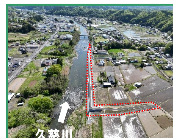
工事箇所の全景（上流から）
