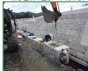
堤脚水路の工事を行っています
