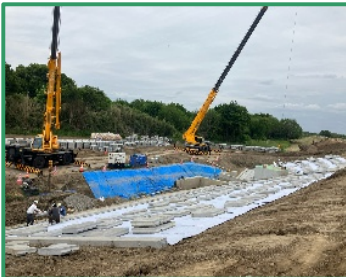
ブロック張りの工事を行っています 堤外盛土の工事を行っています
