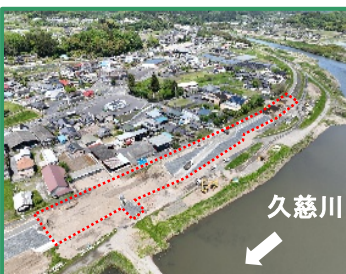
工事箇所の全景（下流から）
