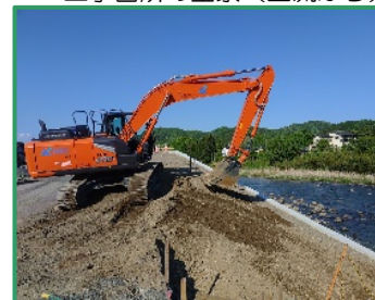
堤防盛土の工事を行っています
