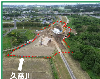
工事箇所の全景（上流から）
