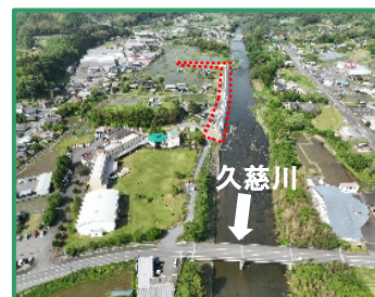
工事箇所の全景（下流から）
