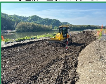
堤防盛土の工事を行っています
