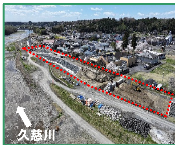
工事箇所の全景（上流から）
