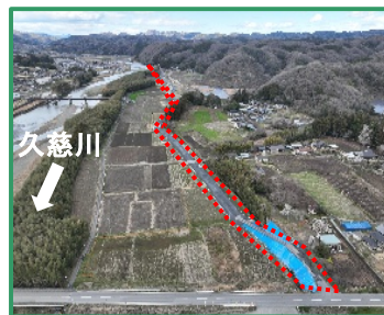
工事箇所の全景（下流から）
