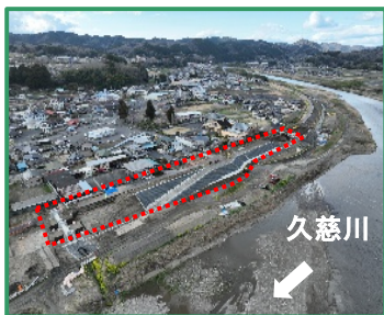
工事箇所の全景（下流から）
