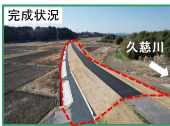
R5久慈川右岸本宇留野地先築堤工事 (株式会社井坂組)
