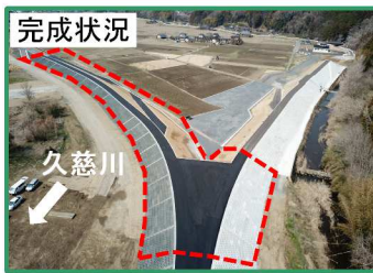
R5久慈川左岸西野内地先築堤工事 (高橋建設工業株式会社)
