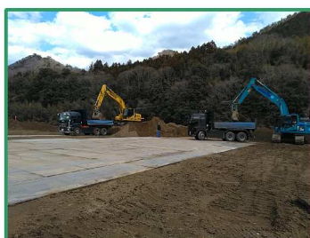
河道掘削を行っています
