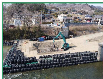
掘削作業を行っています
