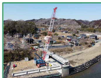
旧橋の撤去を行っています
