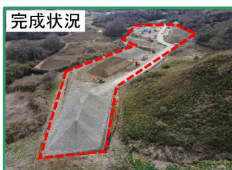
R5久慈川土砂改良(その2)工事 (菅原建設株式会社)
