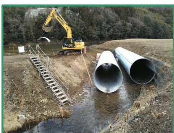
コルゲートの設置を行っています
