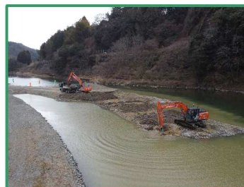
河道掘削を行っています
