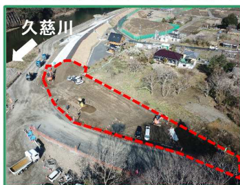
工事箇所の全景 (下流から)
