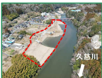
工事箇所の全景 (下流から)
