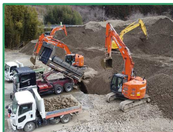
盛土材の振分けを行っています
