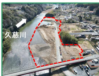
工事箇所の全景 (上流から)
