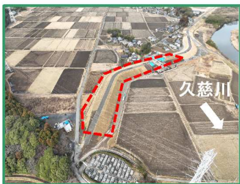
工事箇所の全景 (下流から)
