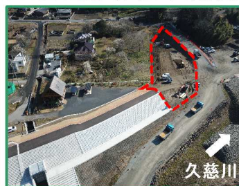
工事箇所の全景 (上流から)
