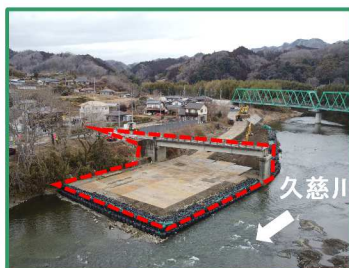
工事箇所の全景 (下流から)
