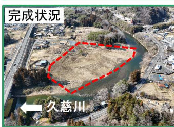
R5久慈川右岸下津原地先河道掘削工事 (北都建設工業株式会社)
