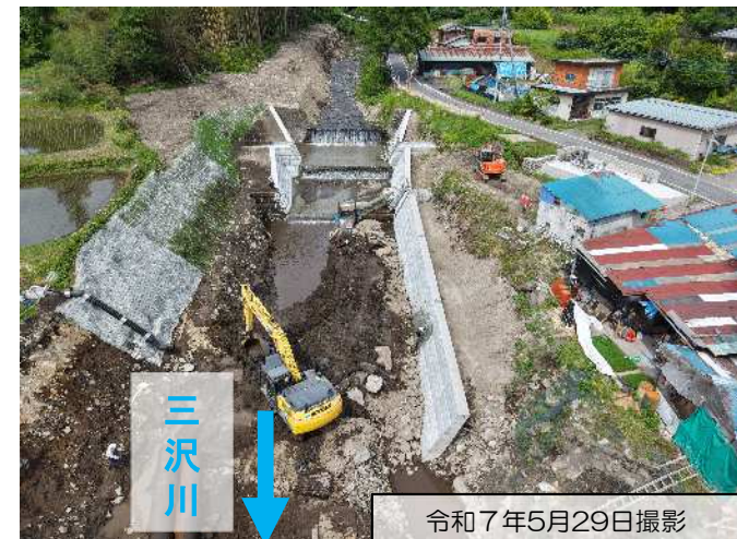
第二床固工下流から上流方向
