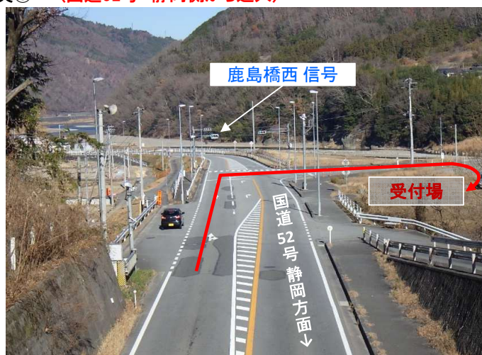
写真② (国道52号 甲府側から進入)
