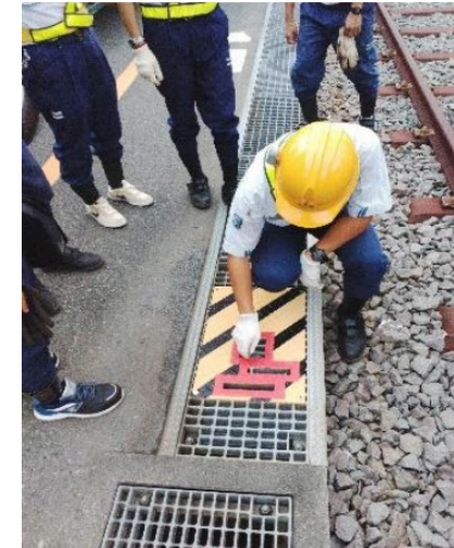
危険品流出防止装置の取扱い
