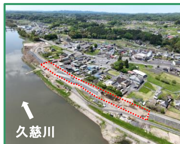
工事箇所の全景（上流から）
