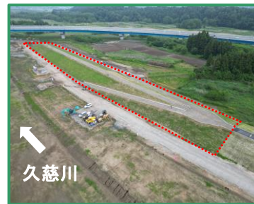
工事箇所の全景（上流から）
