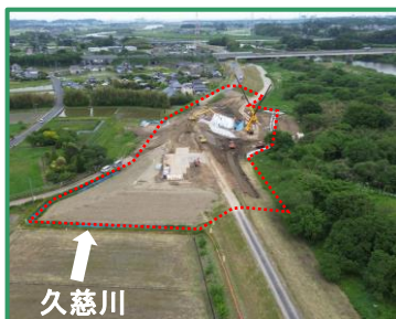
工事箇所の全景（上流から）
