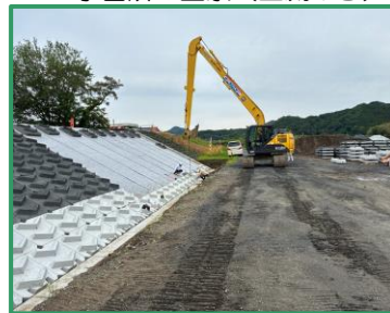
ブロック張りの工事を行っています
