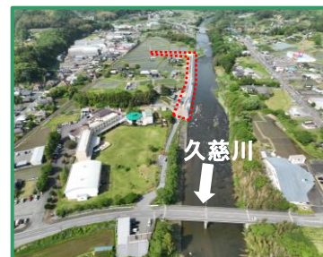
工事箇所の全景（下流から）
