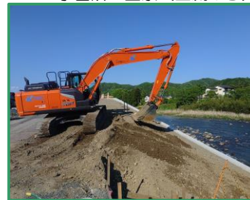
堤防盛土の工事を行っています
