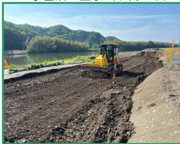
堤防盛土の工事を行っています
