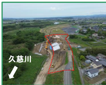
工事箇所の全景（下流から）
