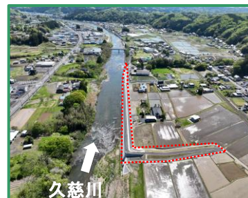
工事箇所の全景（上流から）
