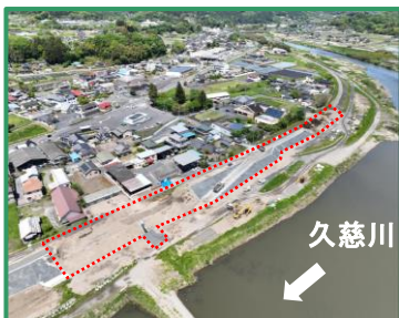
工事箇所の全景（下流から）
