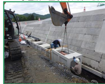
堤脚水路の工事を行っています
