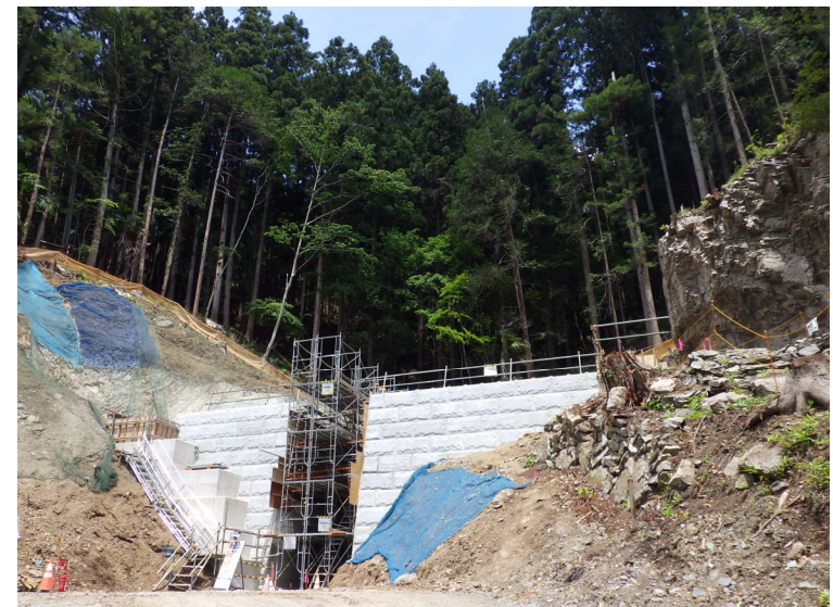
鋼製堰堤本体工
