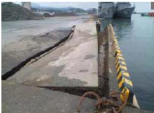
岸壁の破損
