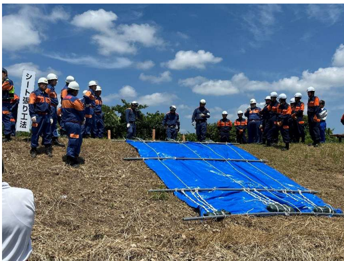
(シート張り工法)
