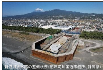
新沼川放水路の整備状況（沼津河川国道事務所、静岡県）
