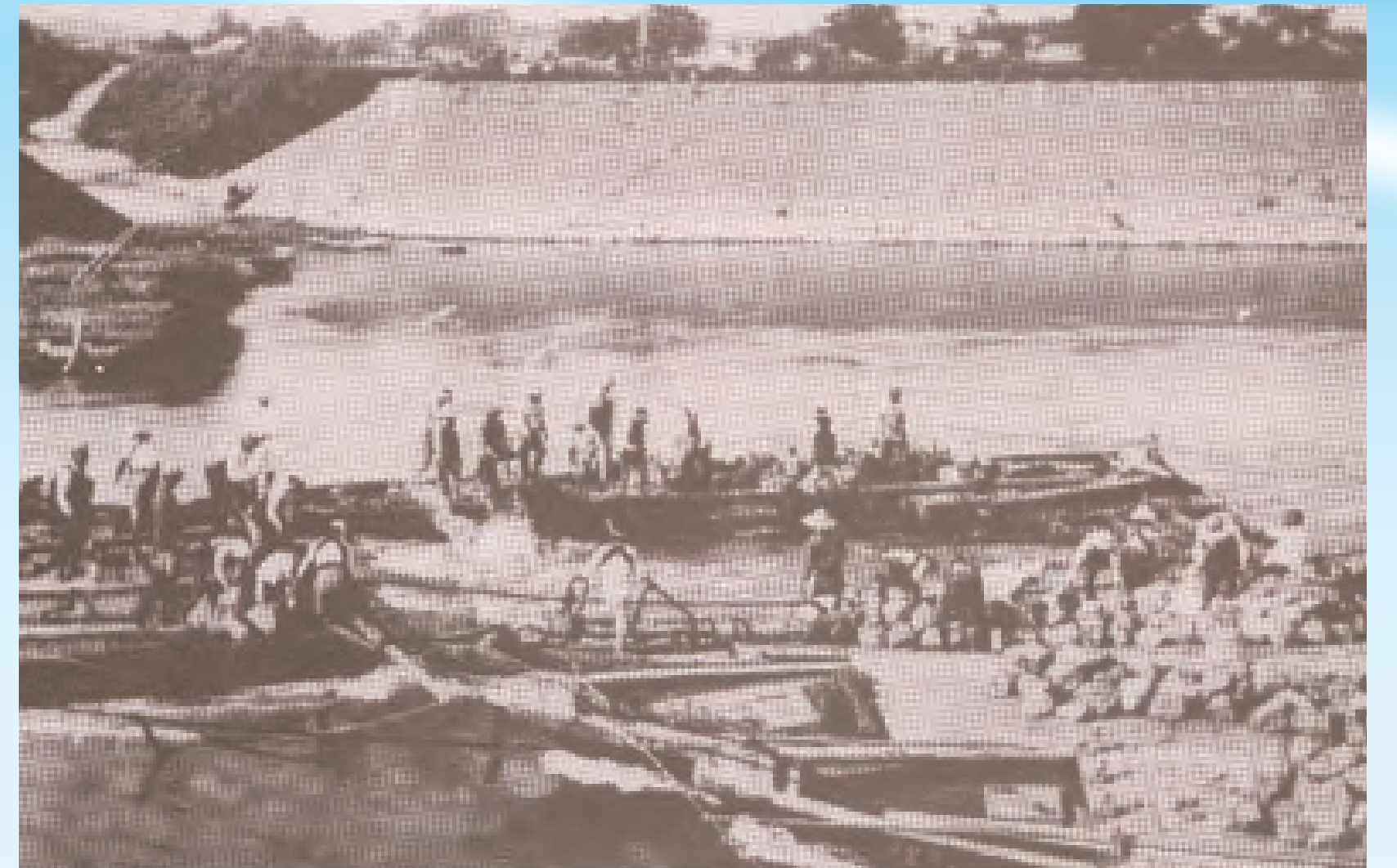
江戸川棒出し改築工事(粗朶沈床の詰石)
