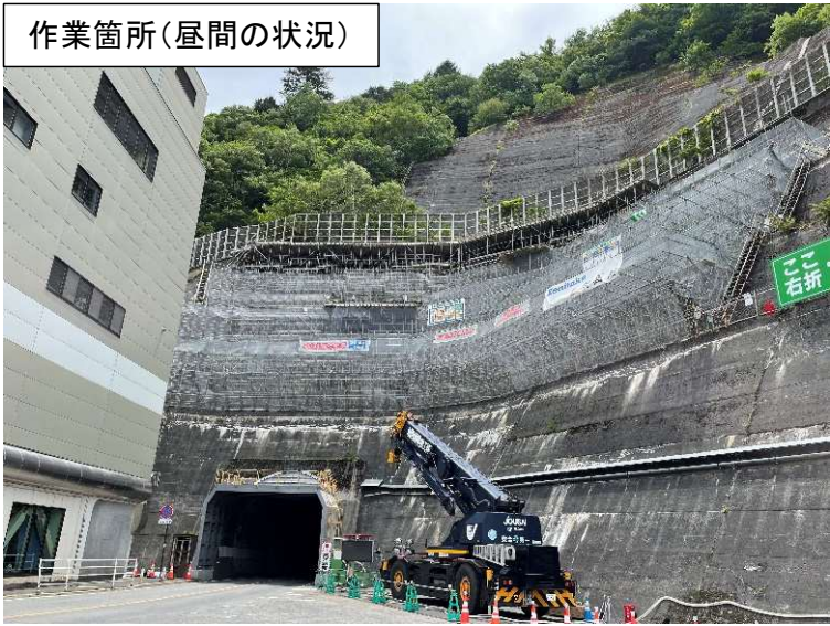
新入山隧道坑口部 法面補強工
