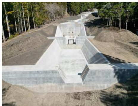
塩島沢第三砂防堰堤(R5年度完成)
