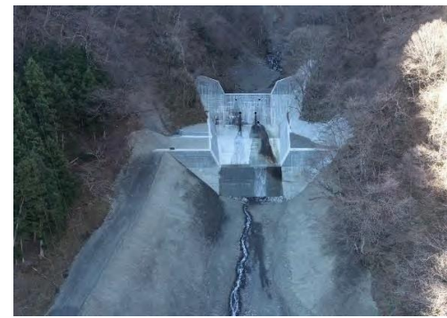
池の沢第三砂防堰堤工事(R5年度完成)
