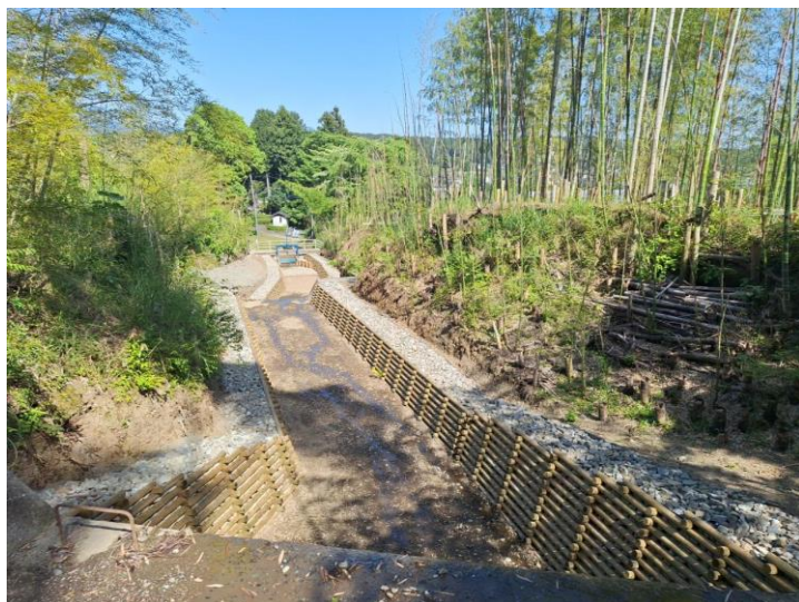
流路工により侵食を防止し溪流を安定化
