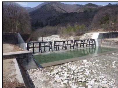
尾白川第三砂防堰堤
