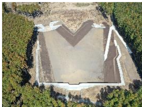
春沢遊砂地工(R5年度完成)
