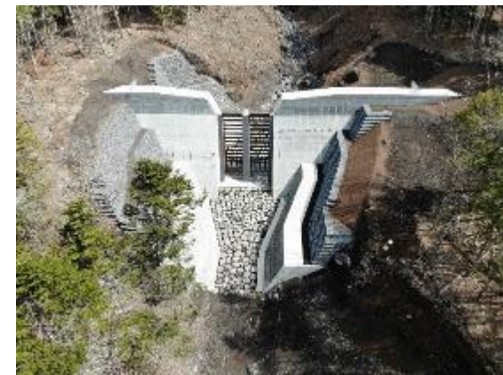
大久保第2砂防えん堤工(R7.3完成)
