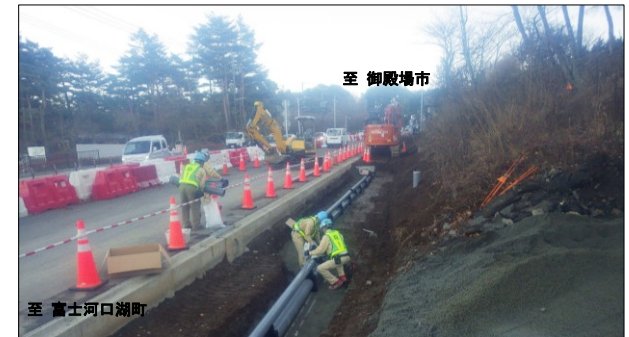
② 工事状況
