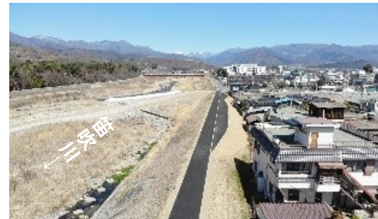
管理用通路の状況
