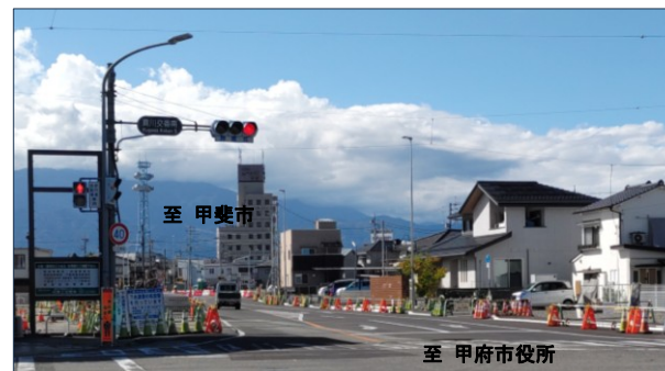
② 工事状況(貢川交番南交差点付近)
