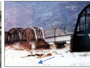
東海道本線鉄橋の流失
