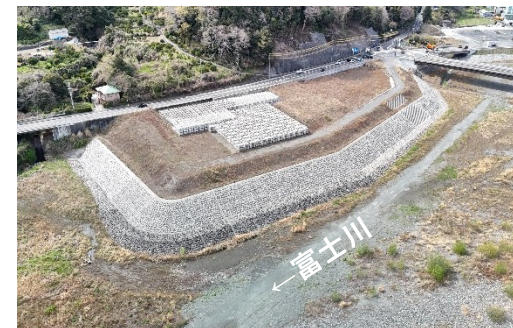
資材備蓄状況 (R7.4)
