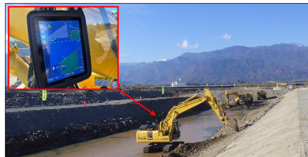
ICT建設機械による掘削（釜無川）
