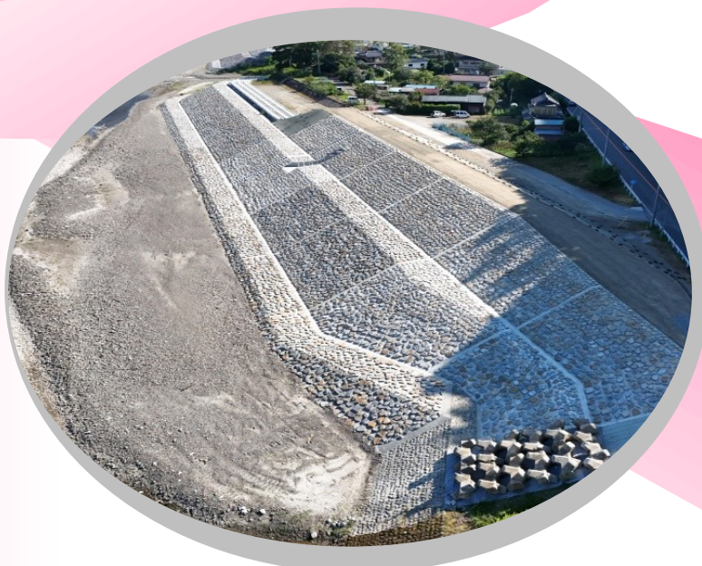
富士川 手打沢地区築堤
