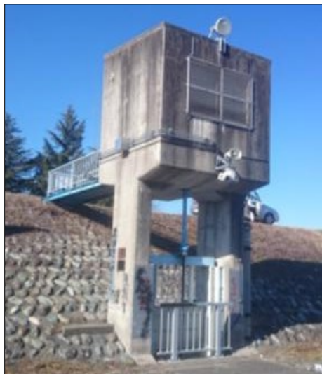
横川排水樋管全景
