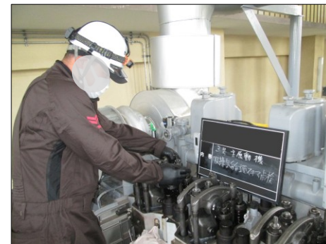
機械設備の点検
