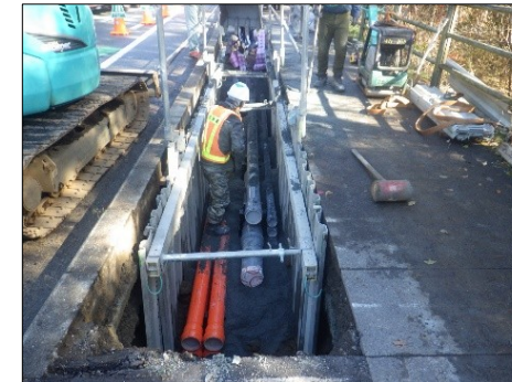
施工状況(鳴沢電線共同溝)
