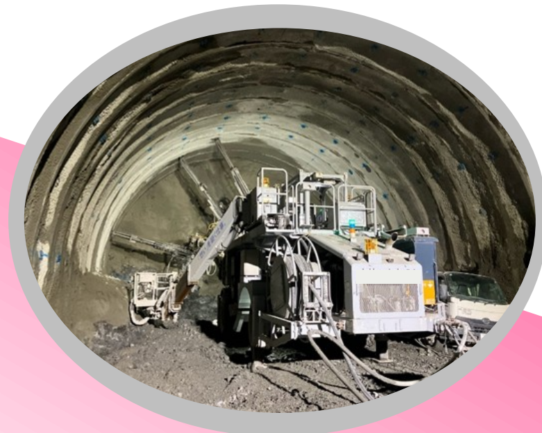
国道20号新笹子トンネル改修
