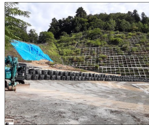
応急復旧工事後（現状）
