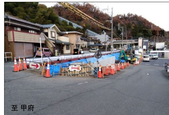
② 施工状況(全景)
