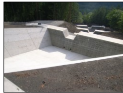
塩島沢堰堤群(富士川砂防事務所)
