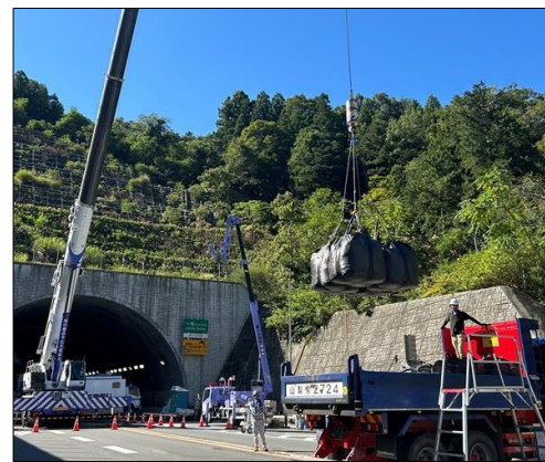
応急復旧工事の状況
