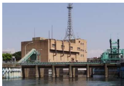
木下川排水機場(東京都)
