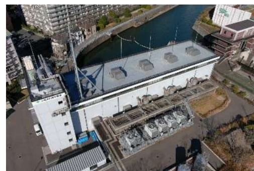
小名木川排水機場(東京都)
