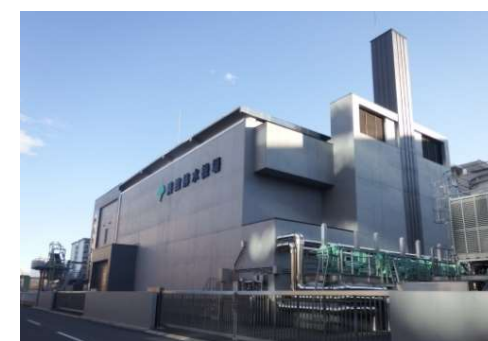
清澄排水機場(東京都)
