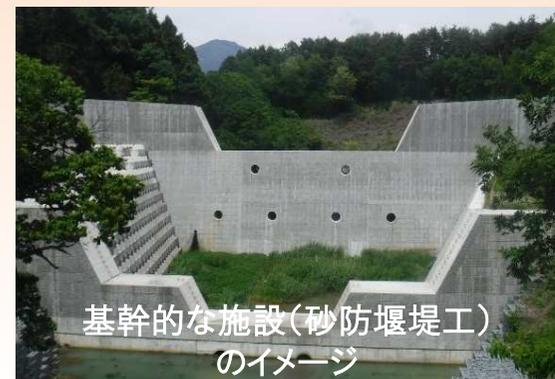
平常時には、最低限の基幹的施設として、砂防堰堤を構築しておき有事に備えます
