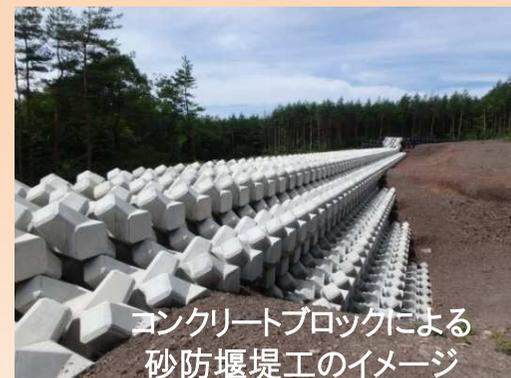
緊急時には、備蓄してあるコンクリートブロックを運搬し、緊急対策施設に砂防堰堤を構築します
