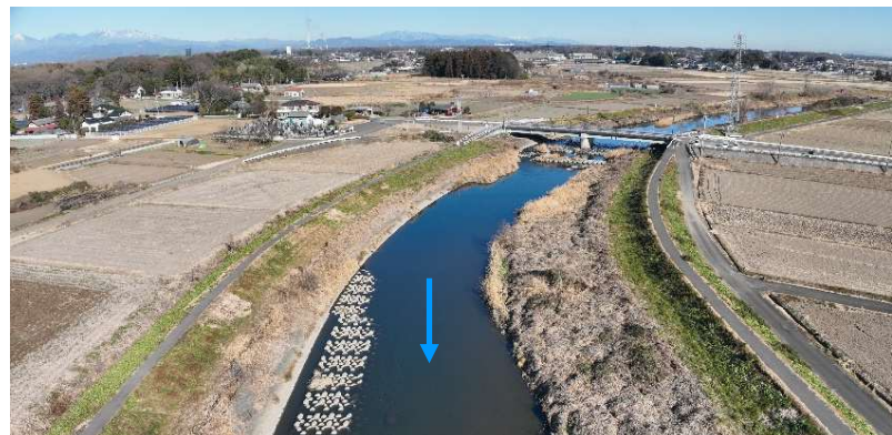
UAVを活用した目視点検
