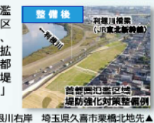
利根川右岸 埼玉県久喜市栗橋北地先▲
