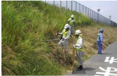
〈機械除草状況（法面）〉
