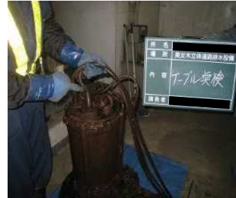
〈排水設備 定期点検状況〉
