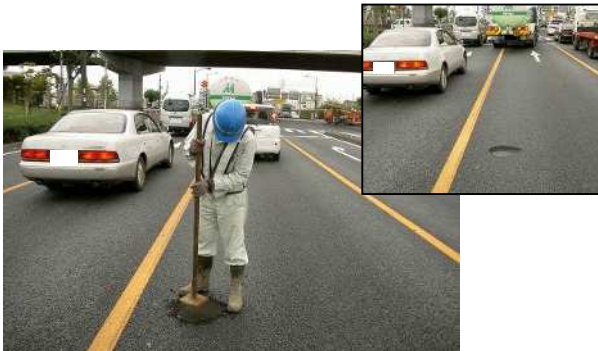
〈路面補修状況（ポットホール補修）〉
