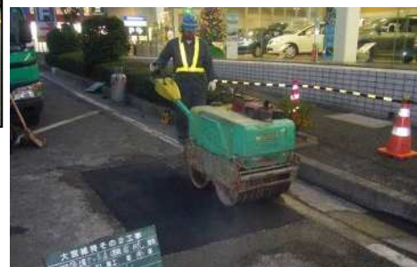
〈路面補修状況（パッチング）〉
