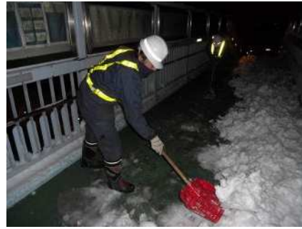
〈歩道橋除雪作業状況〉
