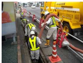
〈側溝清掃状況（機械）〉
