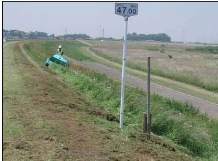
堤防草刈状況
