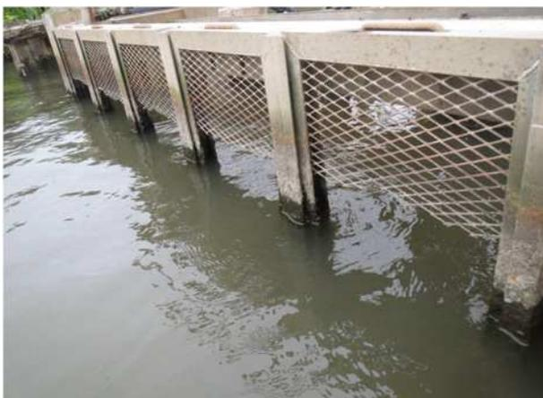
写真-2 スクリーンの脱落
