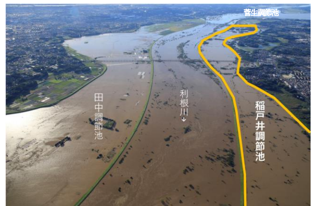
(写真-2 令和元年東日本台風 洪水時)
