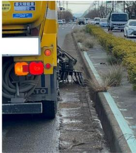
図-6 路面清掃車による除草の試行の様子
