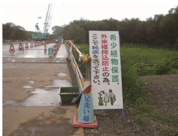
写真-5 足洗い場の設置状況
