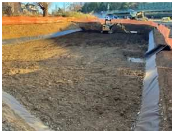
写真-9 道路排水浄化施設の整備状況
