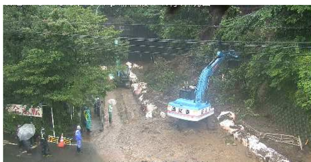
写真-2 無人化施工機械の活用の様子
