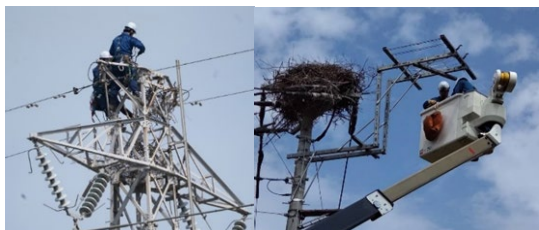
写真-1 巢材撤去（左）・仮設巣台設置（右）
