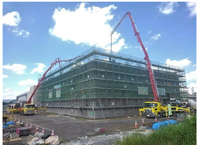
図-4 コンクリートポンプ車の複数台使用状況
