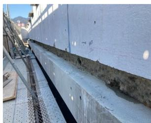
写真-5 水切り部先行施工
