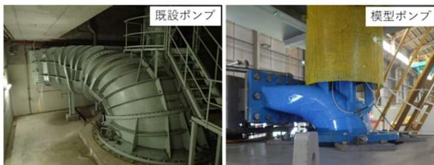
図-4 八潮排水機場3号既設ポンプ及び模型ポンプ
